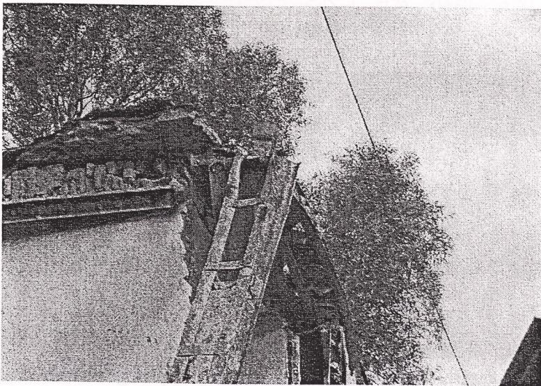
شکل (۱۰): ضعف طراحی ستون‌ها که ورق‌های اتصال ناکافی و نامناسب می باشند
