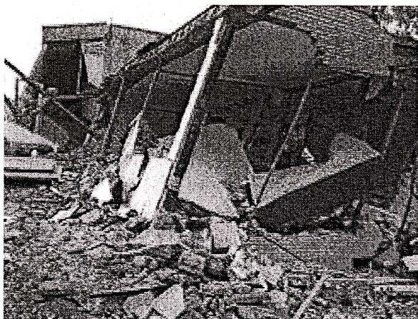
شکل (۹): عدم وجود مهاربند در سازه که موجب تغییر مکان جانبی حدود ۱ متر و خسارت به سازه شده است
