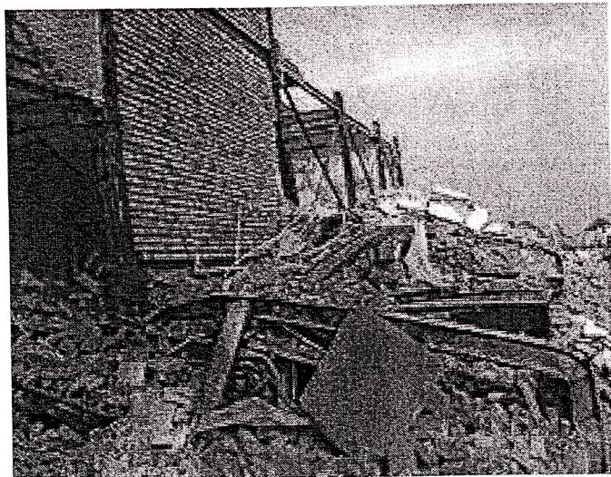
شکل(۲): نمونه‌ای از ساختمان‌های فولادی در بم با اجرای نامناسب
