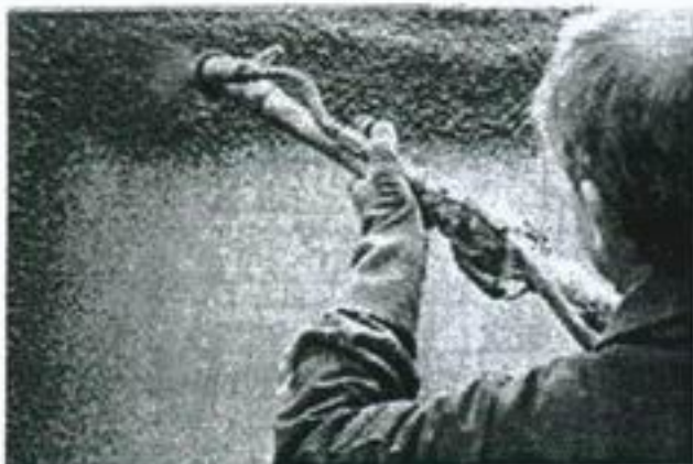
شکل (۶) روش اجرای مواد نفوذگر بوسیله اسپری کردن
