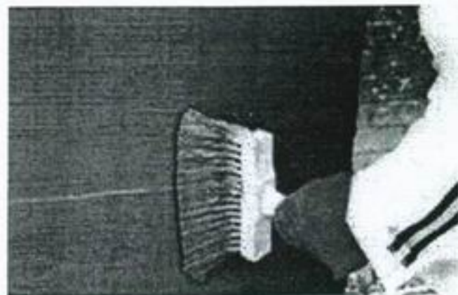
شکل (۵) روش اجرای مواد نفوذگر با قلم مو
